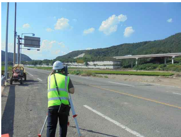
광파기를 이용한 측량 작업
